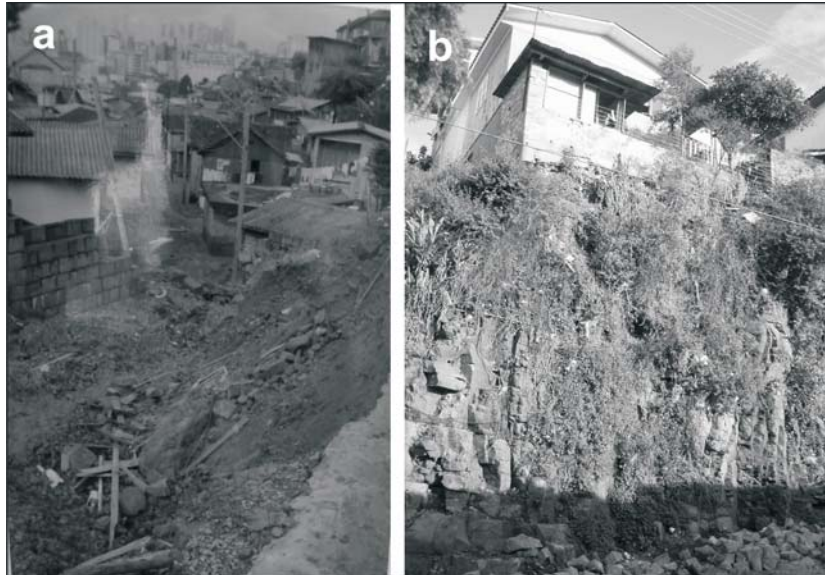
Figura 7. (a) Escorregamento em área de corte. (b) Exposição da rocha vulcânica com diferentes estruturas.
