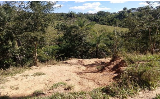
Figura 7 – Erosão (área II)
