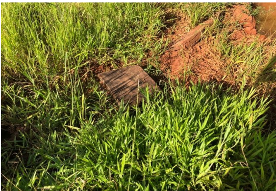
Figura 16 – Cercamento de Nascente (área II)
