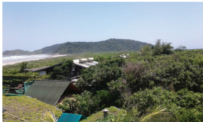
Figura 6 – Telhado verde da pousada B com vista parcial dos chalés
