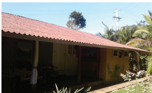
Figura 3 – Telhado da pousada A com potencial fotovoltaico
