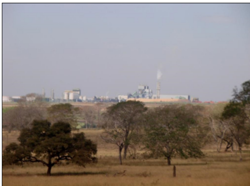
Figura 3 – Usina ETH Bioenergia S/A, Unidade Rio Claro, município de Caçu - GO.
