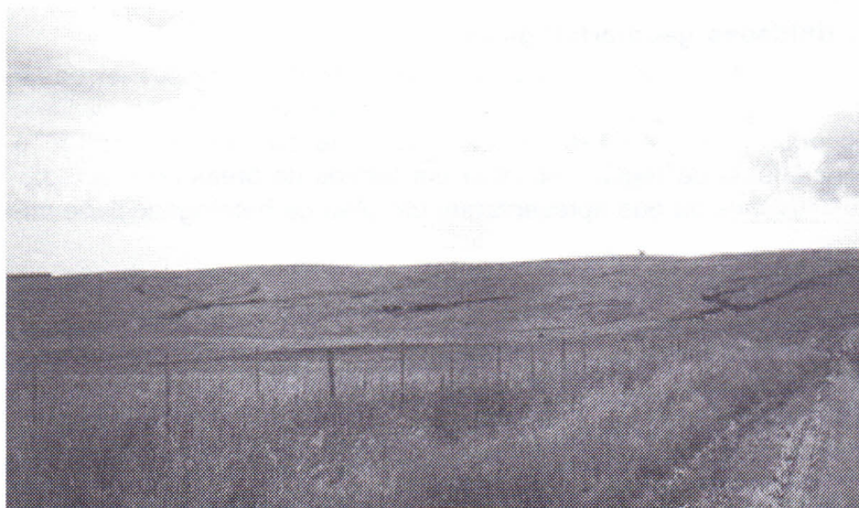
Fig. 3. Colina de arenito com processos erosivos atuantes
