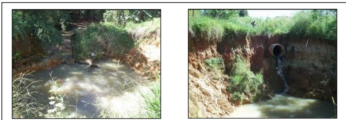
Figura 6 – Erosão em estágio avançado desencadeada por falta de dissipadores de energia e rompimento da rede de drenagem pluvial
