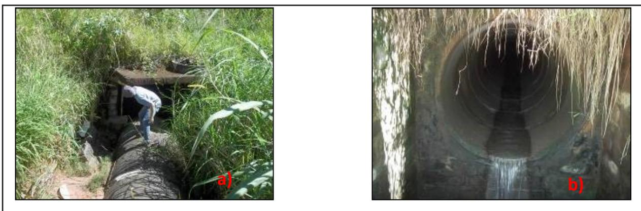
Figura 5 – Rede de drenagem descoberta devido à má execução de obras de engenharia
