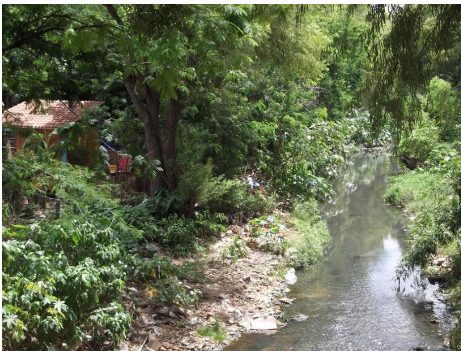
Figura 7: Moradia em situação de risco iminente, próximo à confluência dos canais. Fonte: trabalho de campo.
