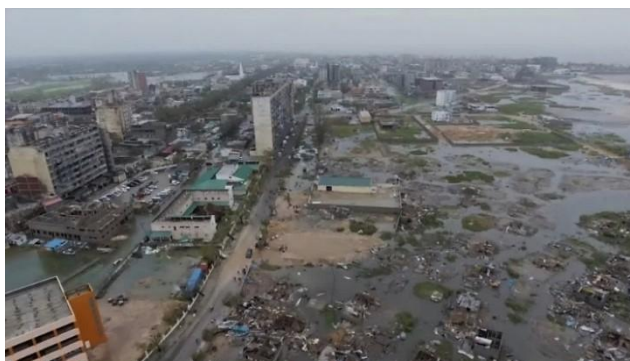
Figura 1 – Região da cidade da Beira destruída.
