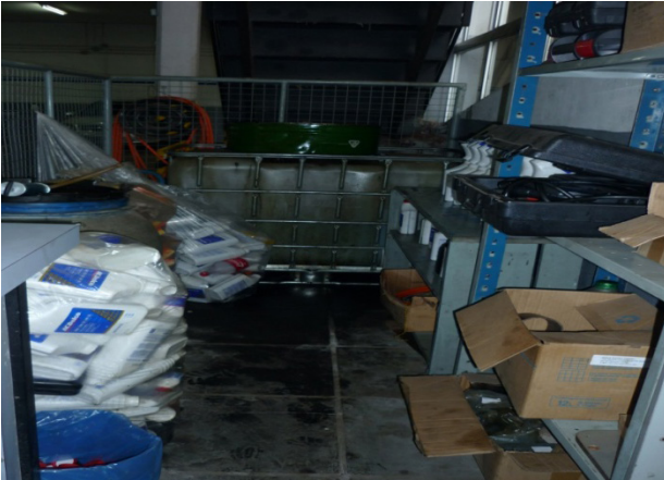
Figura 14. Manchas de óleo próximas ao reservatório de óleo lubrificante. contenção. Fonte. ABRAMAC, 2008.
